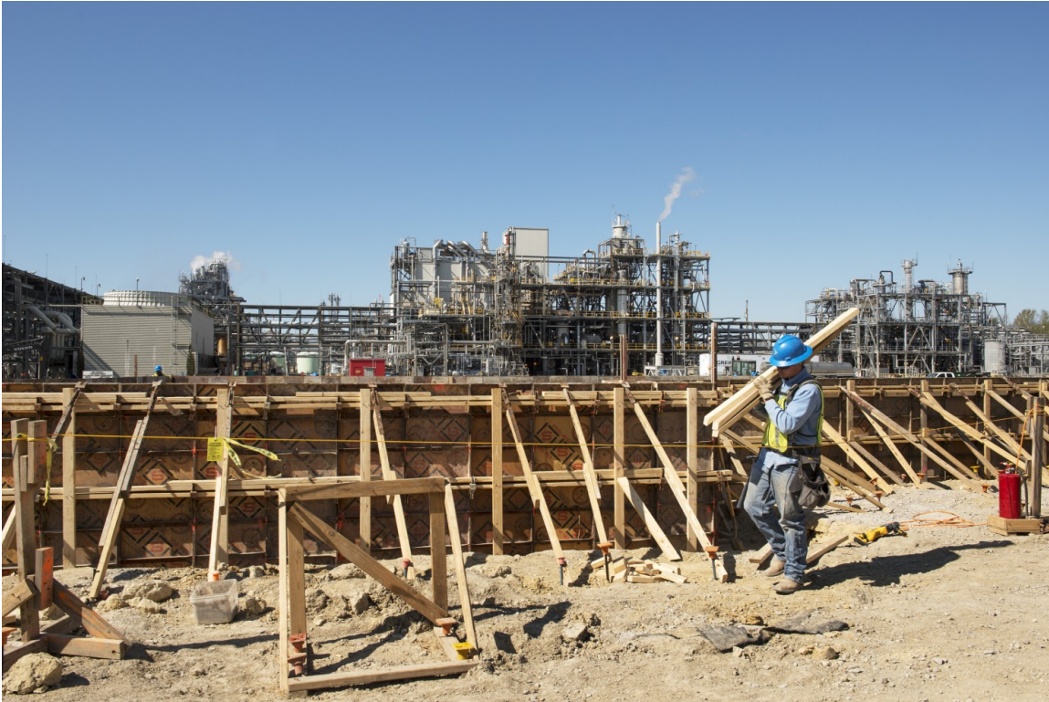
Abbildung 6: Bau einer Ameisensäurefabrik des deutschen Konzerns BASF in Louisiana Quelle: Washington Post, 1. April 2013.
